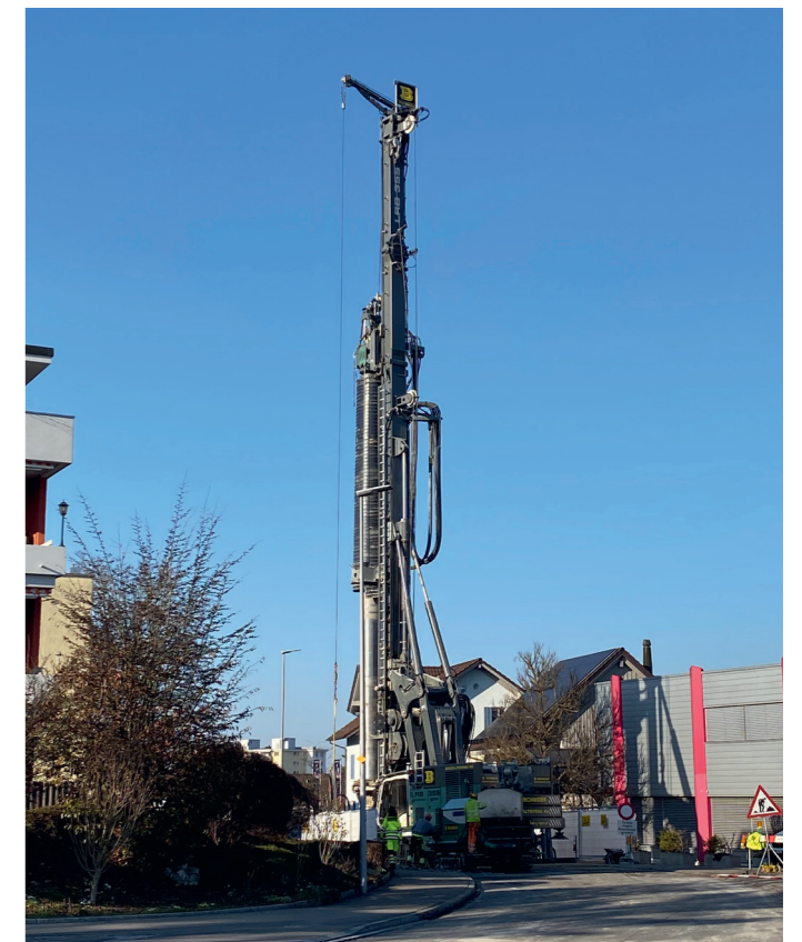
Abbohren des Ankerfeldes mit Doppelkopfbohrungen, Bild Guido Meier, Braumann Tiefbau AG
