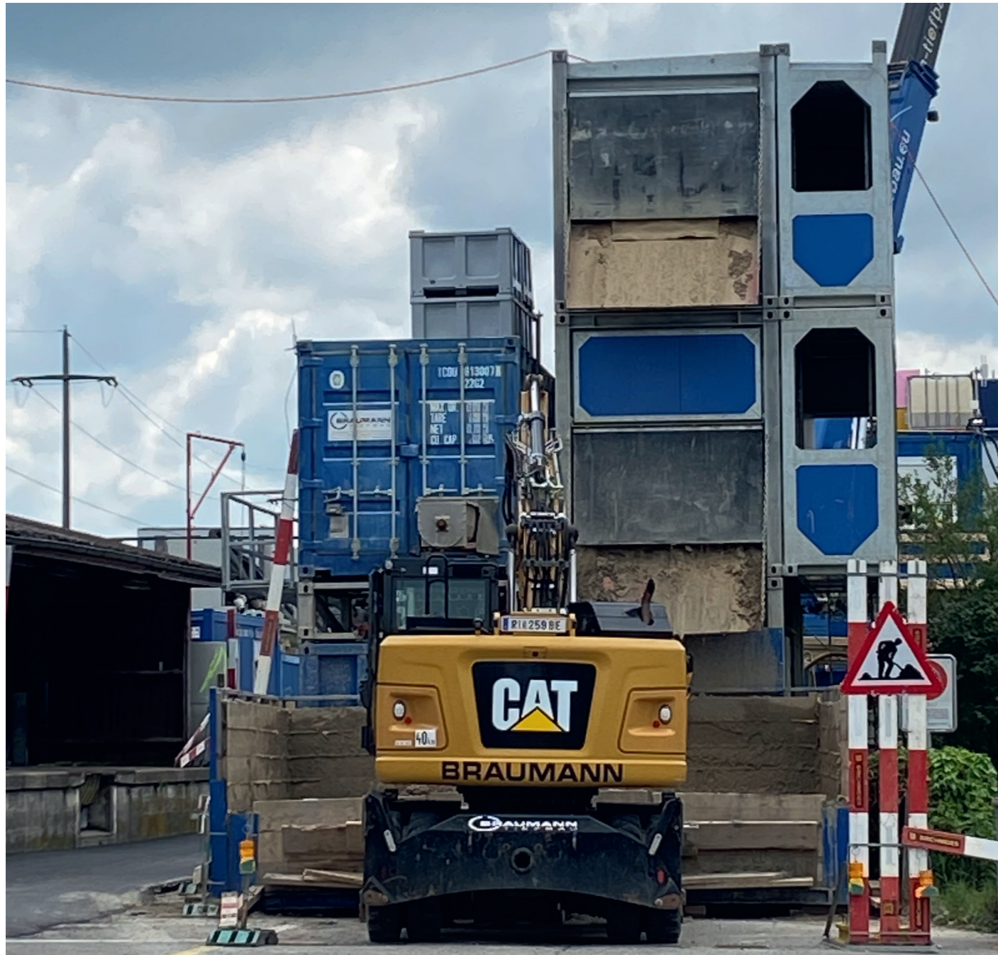
Bohrgutaufbereitung mittels Dekanter und Separationsanlage, Bild Guido Meier, Braumann Tiefbau AG
