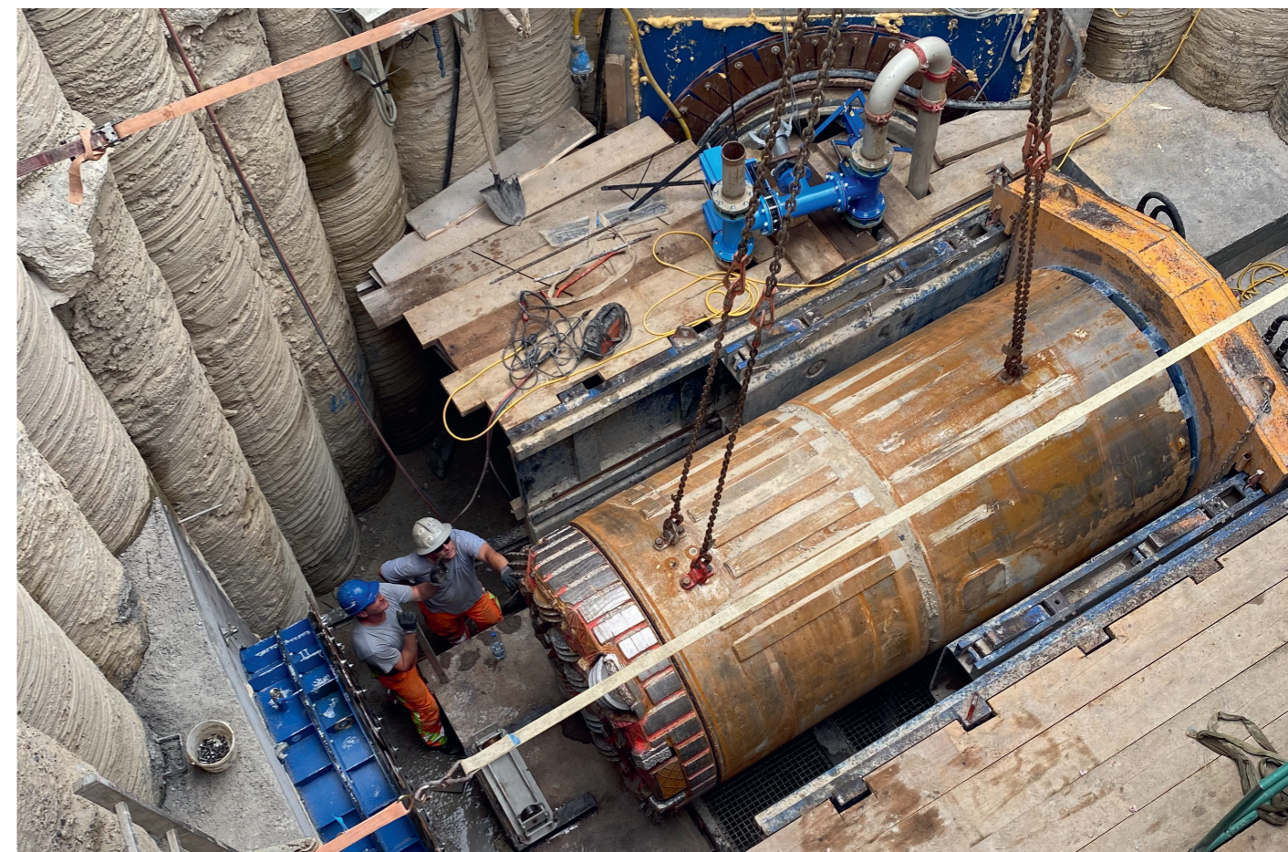
Start-/ Zielbaugrube Bahnhofstrasse / Zürcherstrasse, Bild Guido Meier, Braumann Tiefbau AG
