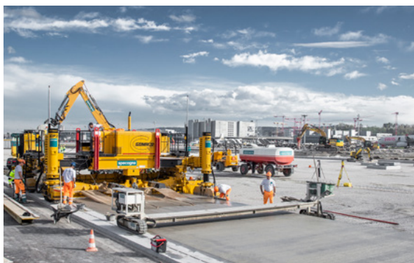
Revêtement en béton à l'aéroport de Zurich pour les «Stands Delta Sud» (photo : Specogna Bau AG)
