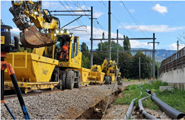
Fahrbahnerneuerung Delémont – Laufen im Sommer 2023 (Bild: Walo Bertschinger AG)
