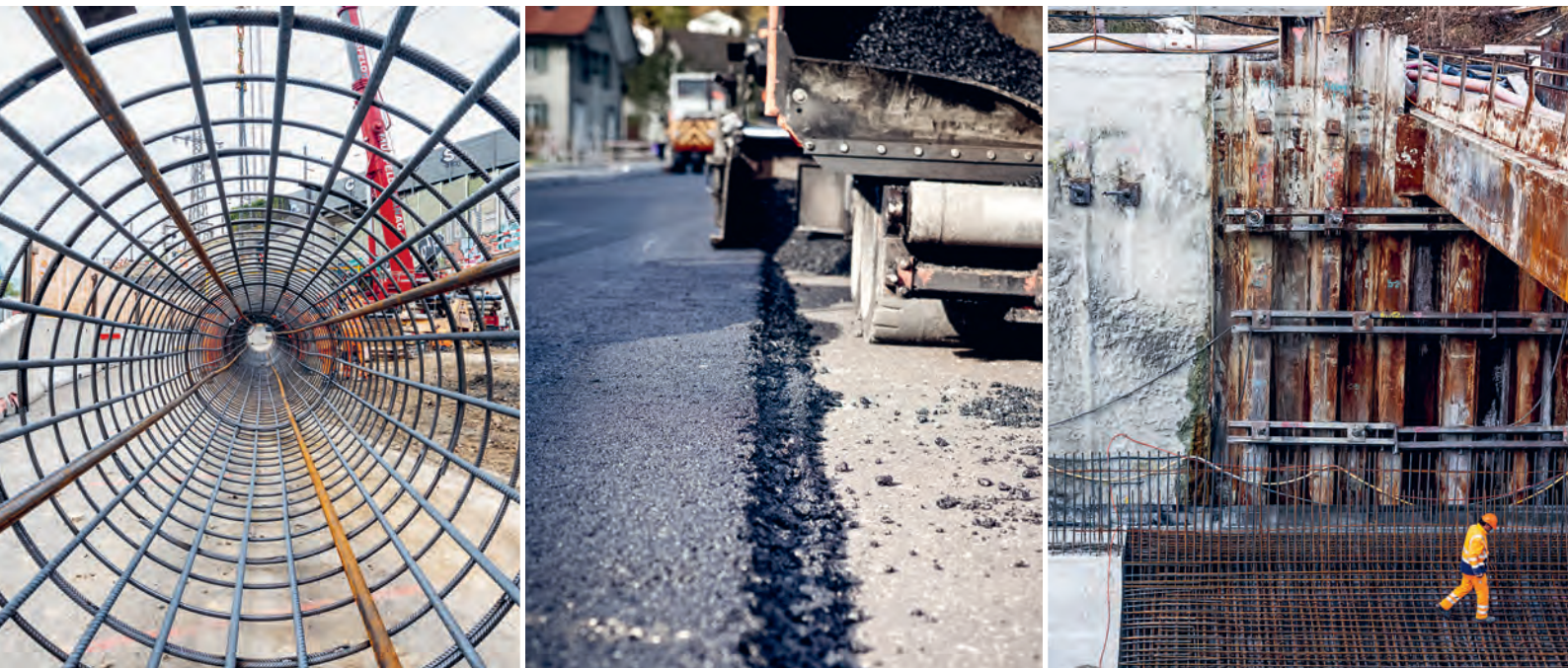
Lieferengpässe diverser Baumaterialien sorgten für Nervosität auf dem Markt.
