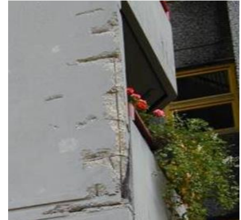
Korrosion Bewehrungsstahl
