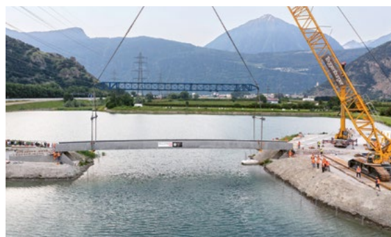
Fig. 5. Passerelle du Rosel, à Martigny [6]
