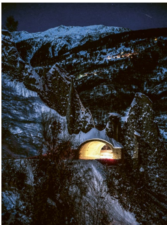
Fig. 4. Tunnel des pyramides d'Euseigne, réalisé en entreprise totale © lumiere.ch
