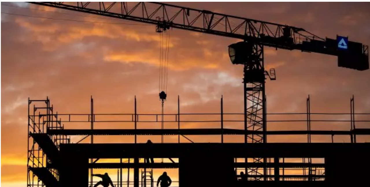
Bauarbeiter arbeiten auf einer Baustelle, während die Sonne aufgeht. - dpa
