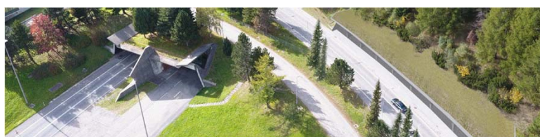
Sanierung Gotthard-Strassentunnel: Infra-Tagung vom 24. Januar 2019 Bundesamt für Strassen (ASTRA), Guido Biaggio
