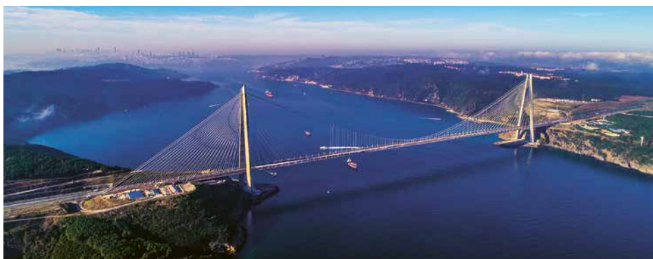
Figure 9 : Le pont Yavuz Sultan Selim en service – un lien entre l'Europe et l'Asie, porte d'entrée d'Istanbul
