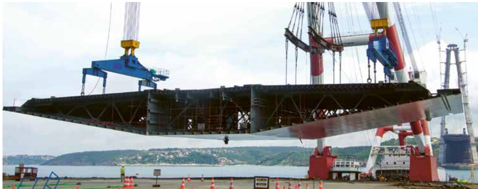
Figure 8: Levage d'un segment type: 24 m de longueur, 58,50 m de largeur, poids 900 to
