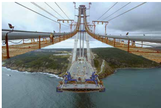
Figure 6 : Illustration des trois modes de suspension du tablier – construction simultanée de la partie en encorbellement haubanée et de la pose des câbles principaux
